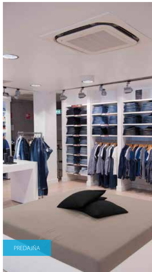
Kazetová jednotka s kruhovým výfukom FXFQ-A: Výfukovanie vzduchu v rozsahu 360° pre optimálnu účinnosť a komfort
