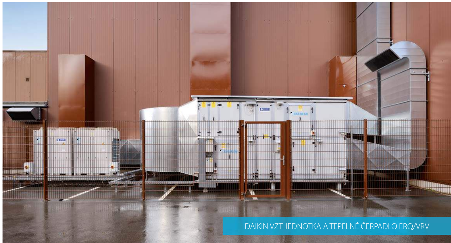
VAM – VETRACIE JEDNOTKY SO SPÄTNÝM ZÍSKAVANÍM TEPLA
